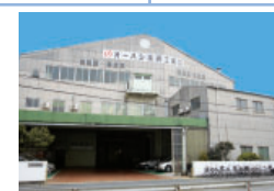
オーハシ技研工業株式会社 本社工場：愛知県東海市 仙台工場：宮城県仙台市 自動車関連部品の製造
