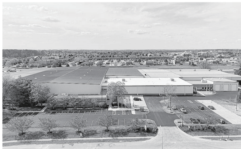
拡張工事が完了した米国拠点
