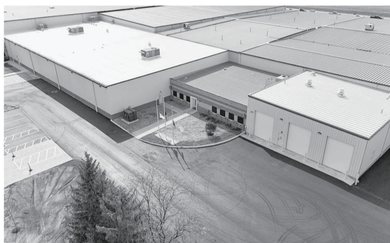
拡張した切削工事（左上白い建物部分）
